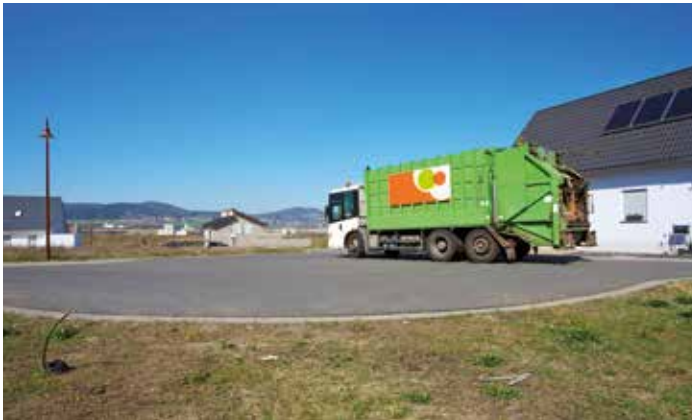
Wendehammer mit ausreichendem Durchmesser
